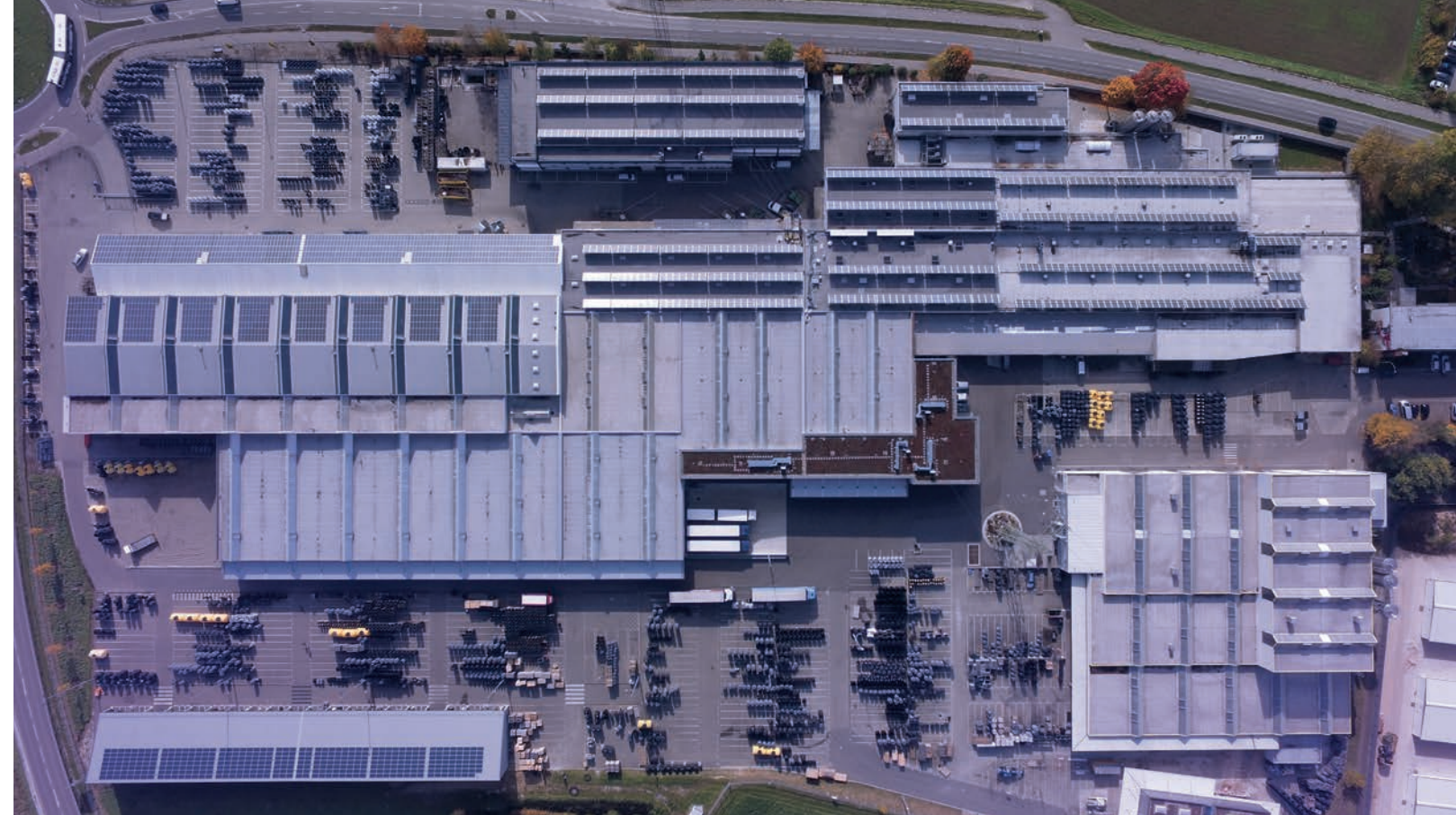
Заводская территория KESSEL, г. Лендинг (Германия)
